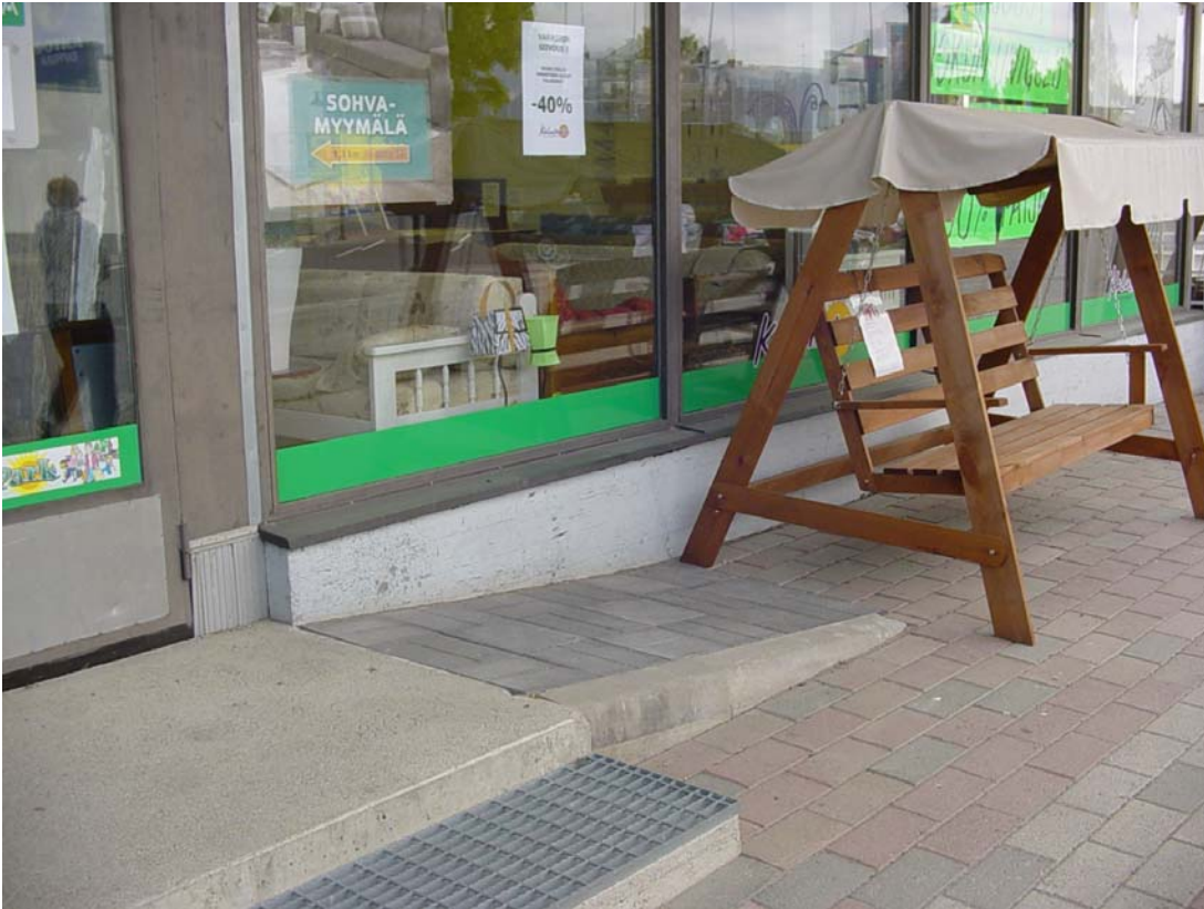
Kuva 1. Luiskista ei ole hyötyä, jos niiden käyttö on tehty mahdottomaksi.
