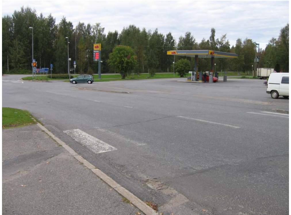
Kuva 43. Yhdystiellä olevan huoltoaseman liittymäjärjestelyt ovat sekavia.
