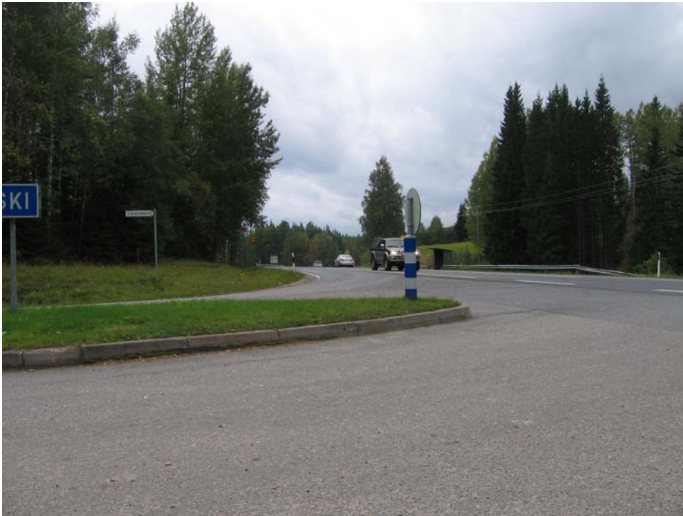
Kuva 48. Siikakoskentien liittymän liikennemäärät ovat kasvaneet selvästi. Liittymä koetaan sekavaksi eikä sitä ole valaistu.
