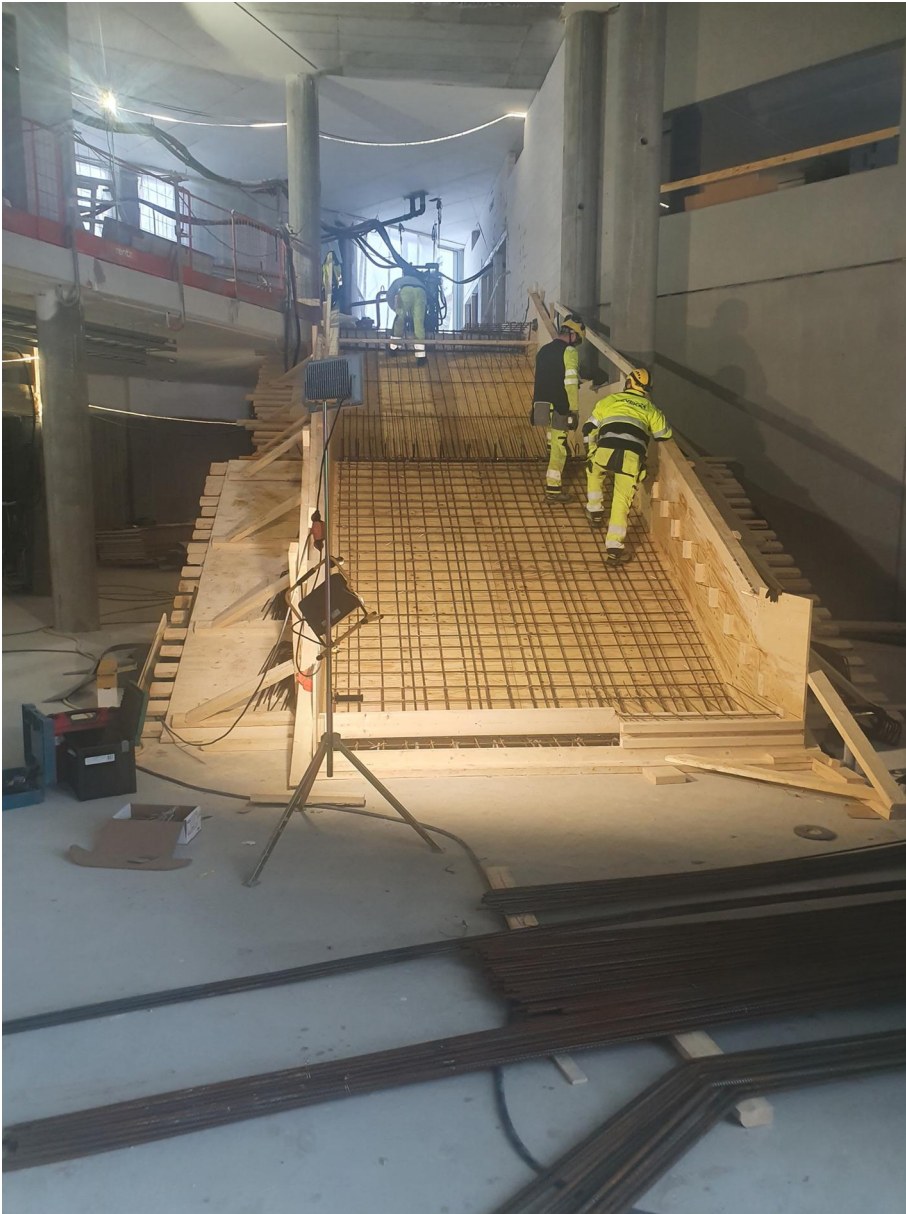
Aulan portaan raudoitustyöt käynnissä
