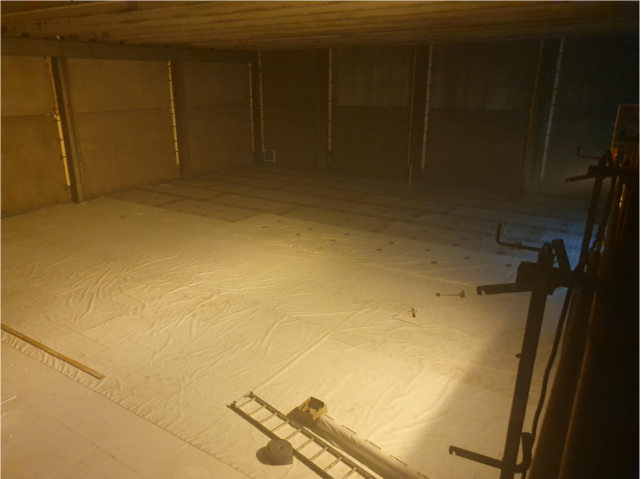
Liikuntahallin valuvalmistelut käynnissä
