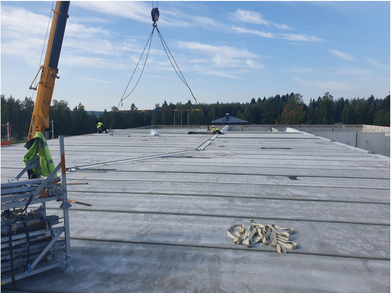
A-lohkon 2 krs ontelolaattojen asennus käynnissä (Alakoulun katto).
