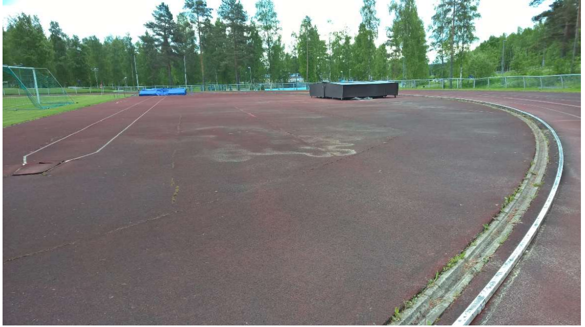
Kuva 7d. Seiväshyppy- ja korkeushyppypääty, päällyste rikkotunut ja painaumia.
