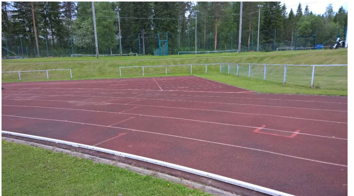
Kuva 7c. Juoksuradan painumia, "patteja" ja korjauksia.
