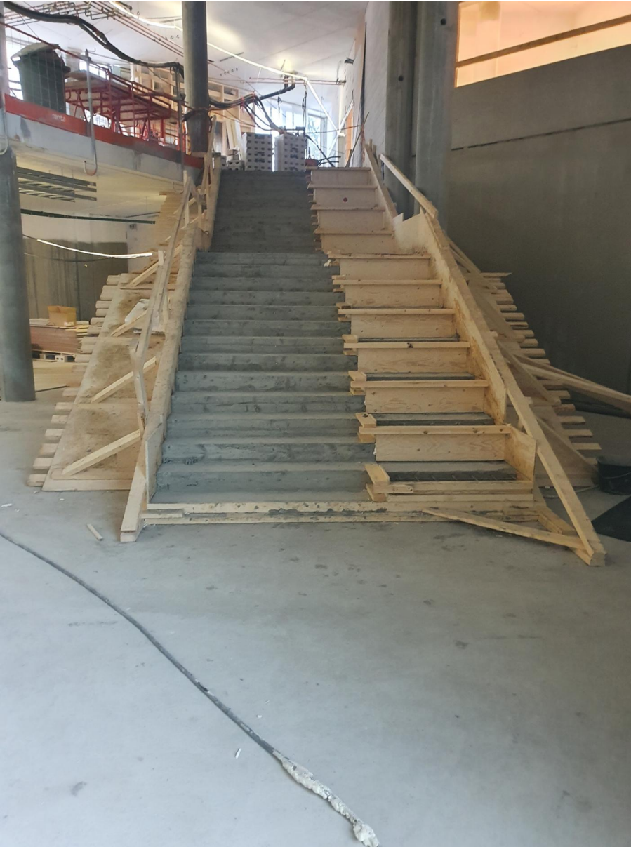
Aulan porras valettuna
