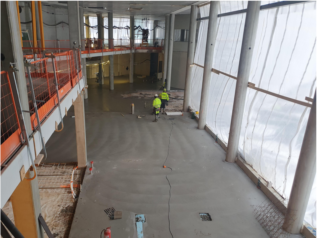
C2-lohkon 1 krs lattiavalu käynnissä.
