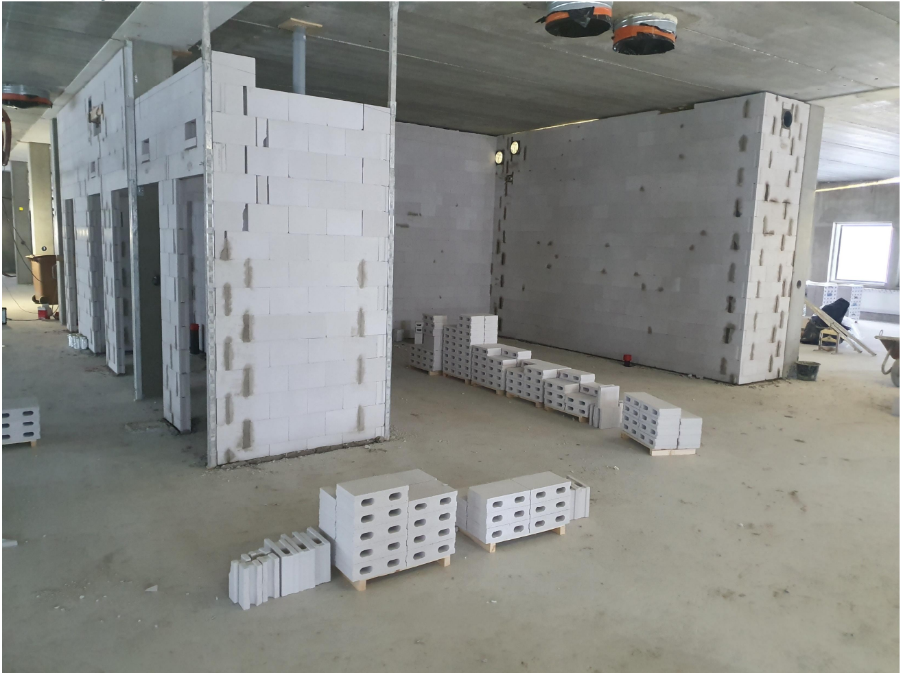
A-lohkon 2 krs väliseinämuuraukset käynnissä.
