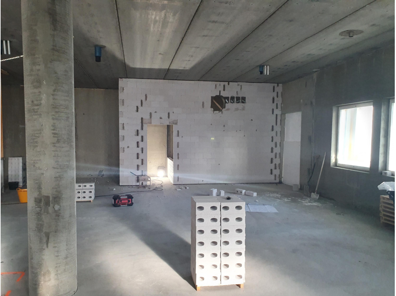
C1-lohkon 1 krs aloitettu väliseinämuuraukset.
