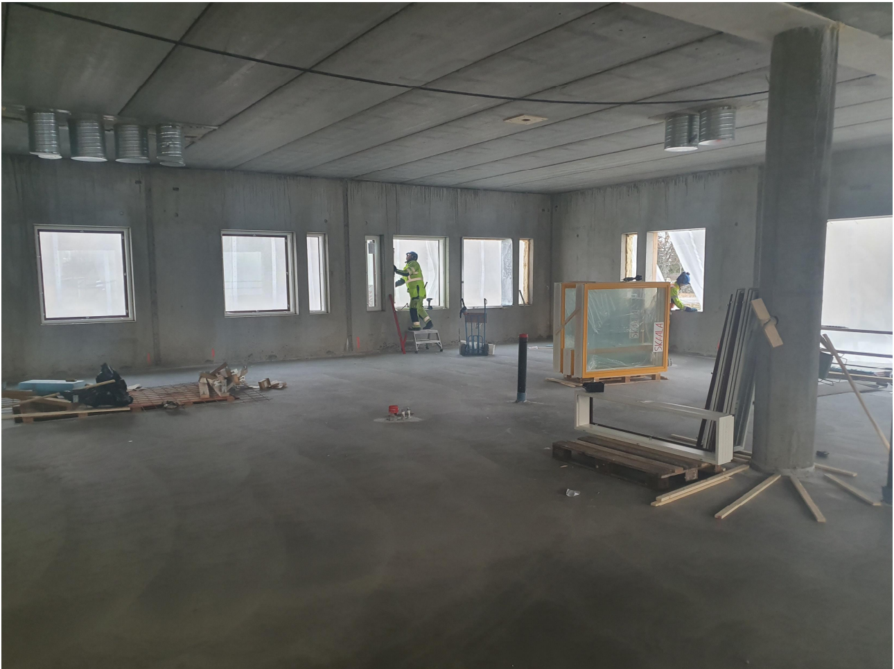
C1-lohkon 2krs ikkuna-asennukset käynnissä.
