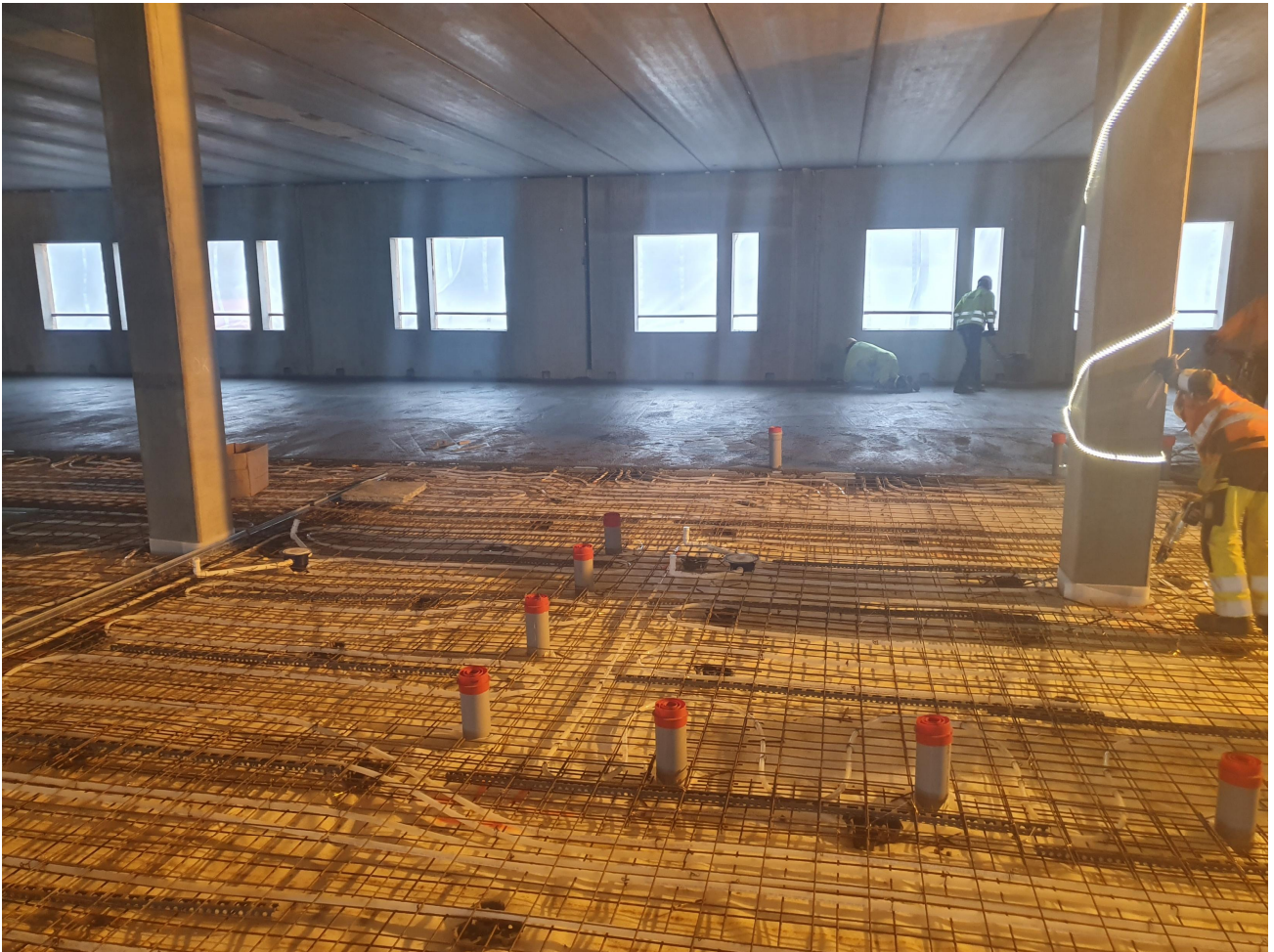
A-lohkon 1krs lattiavalu käynnissä.
