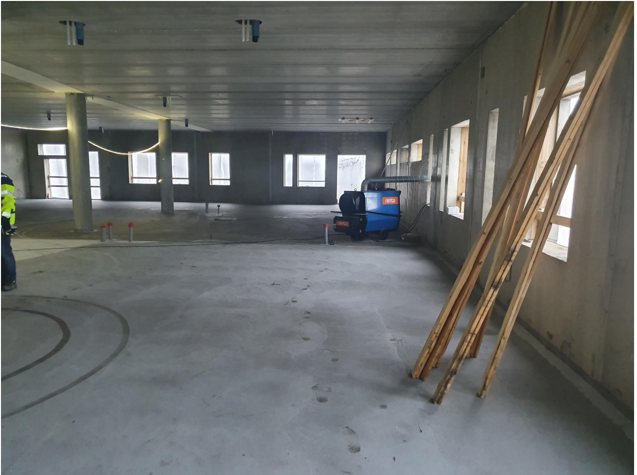
C1-lohkon maanvaraiset lattiat valettu.
