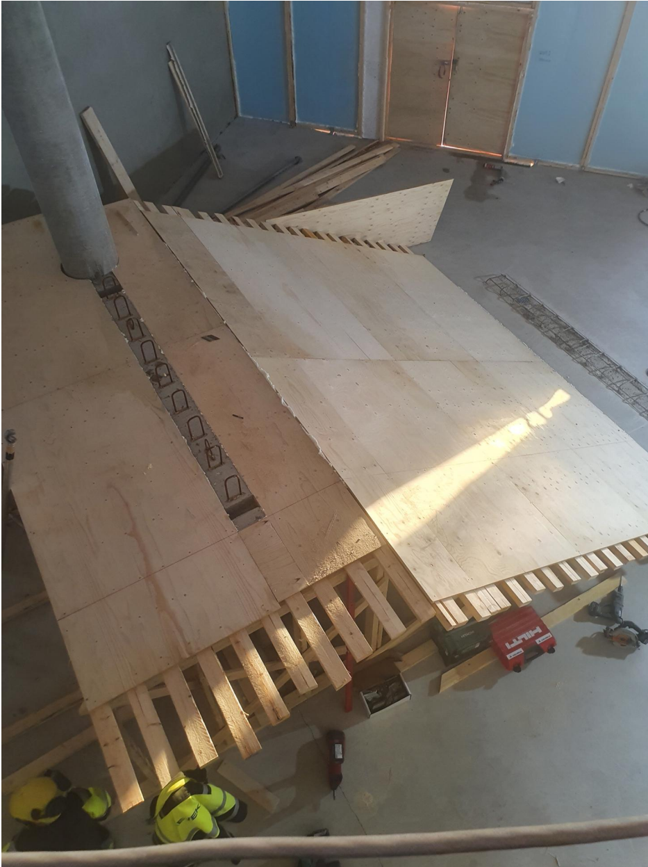
Aulan portaan muottityöt aloitettu
