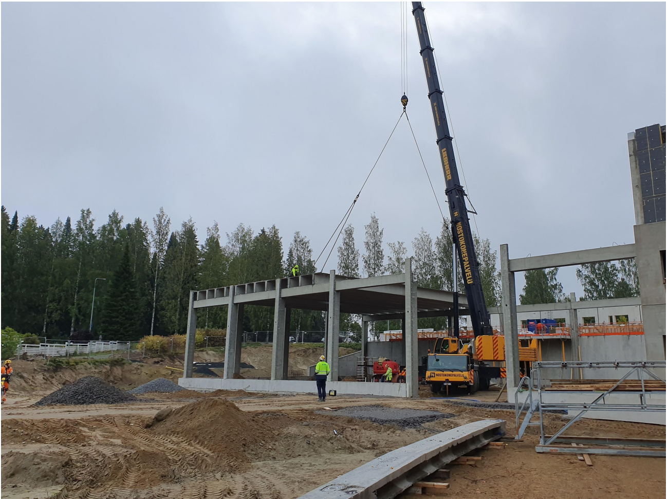
B-lohkon TT-laattojen asennus käynnissä (Liikuntahalli).
