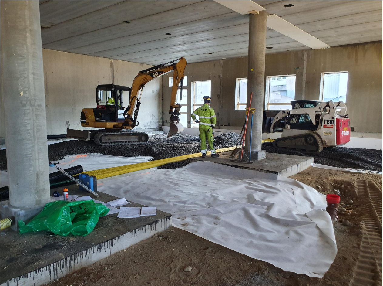
C1-lohkon mv-lattioiden alustäytöt aloitettu.
