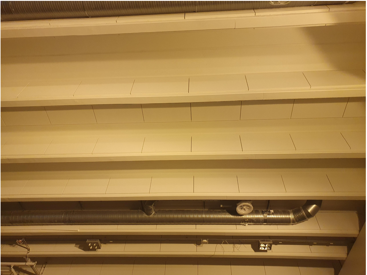
Liikuntasalin katon akustiikkalevyjen liimaus käynnissä
