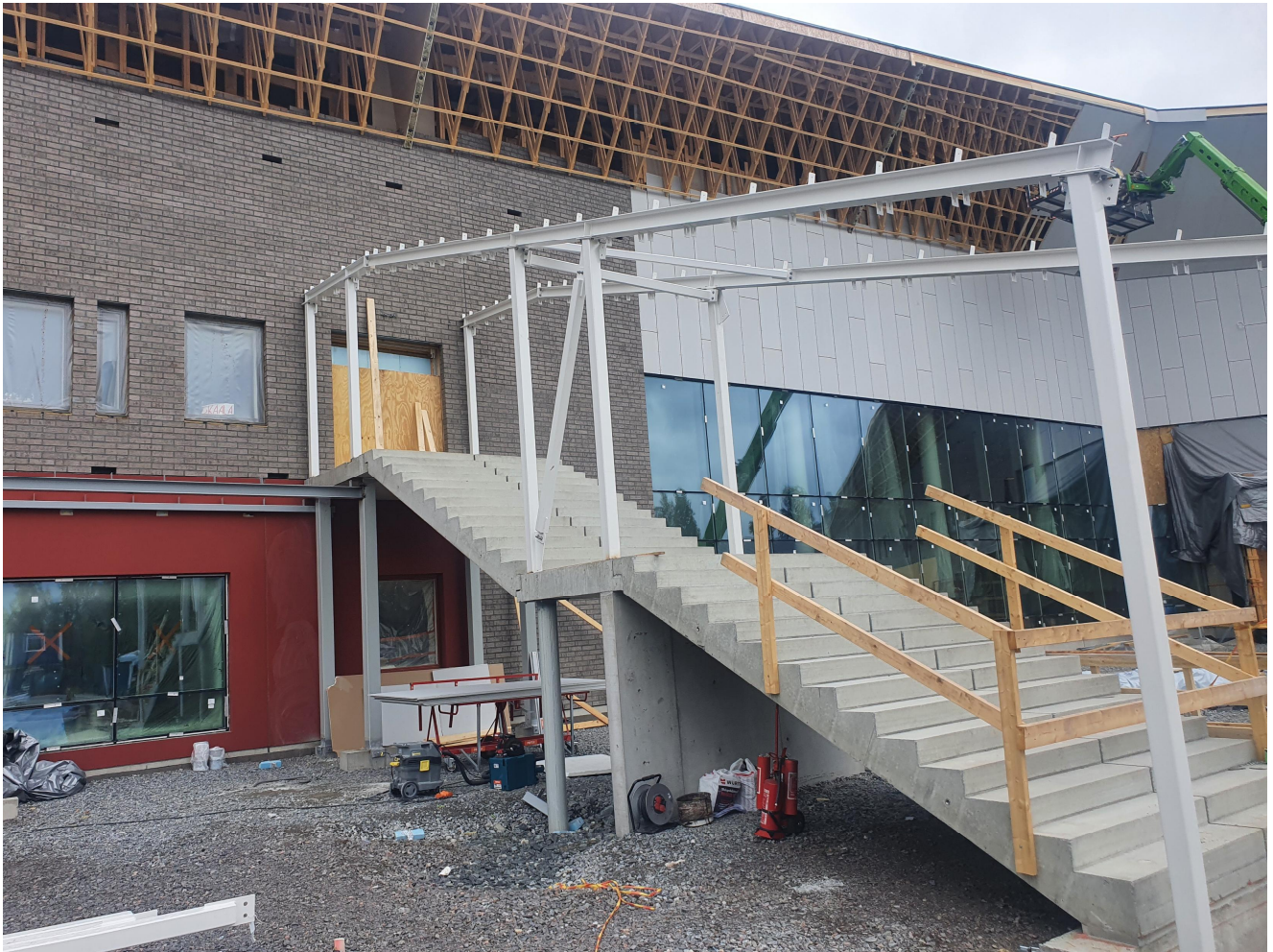
Ulkoportaiden teräsrunko asennus käynnissä
