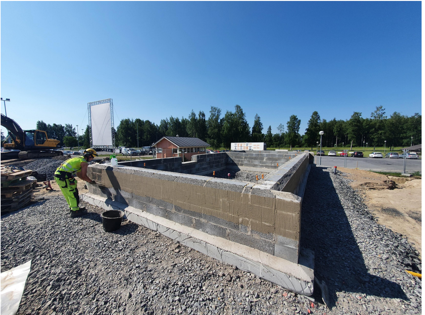
Varaston sokkeli valmistumassa
