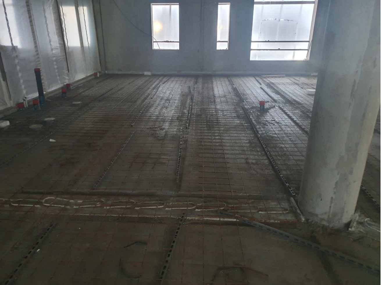
C2-lohkon 2 krs lattiavaluvalmistelut käynnissä.
