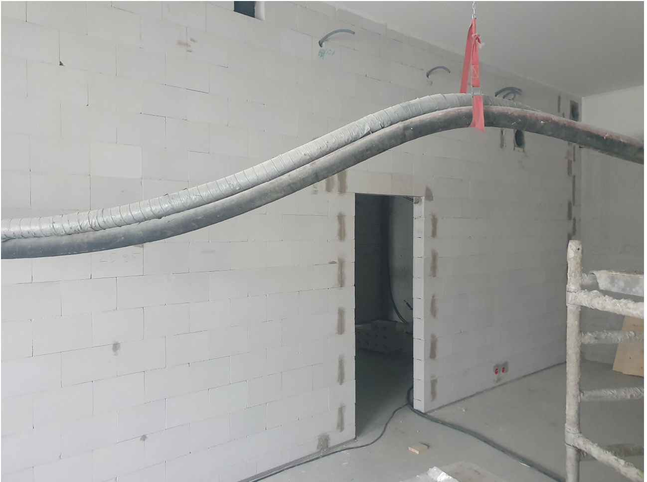
C2-lohkon 2 krs väliseinämuuraukset käynnissä
