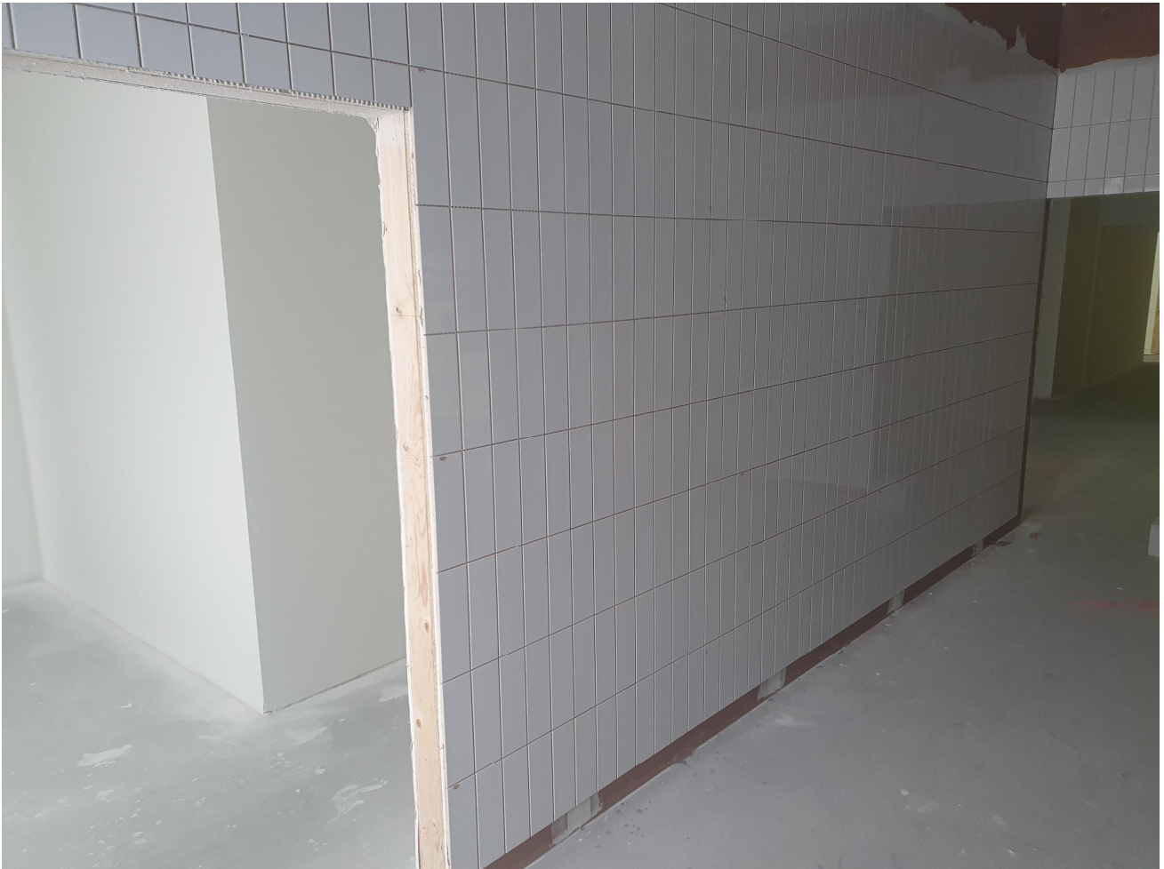
Laatoitustyöt käynnissä A-lohkon 1 krs
